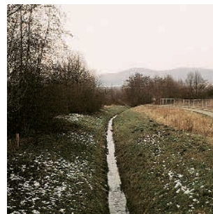
Bild ② Bach vor der Renaturierung (März 1998): Trapezprofil; Betonhalbschalen; gerader Gewässerverlauf.
