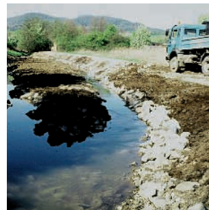
Bild ③ Nach den Baumaßnahmen (Ende April 1998): Gewässerbett ist erweitert; Steine und Sediment wurden eingebracht, eine Insel angelegt, die zur Verzweigung des Baches führt. Lastwagen zeigt, dass schwere Maschinen eingesetzt wurden.
