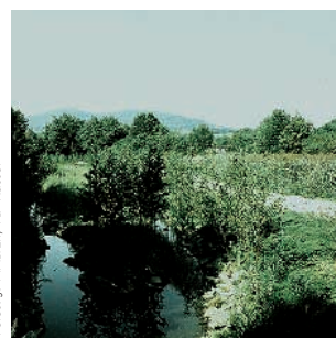
Abb. 7-4 Beispiel für die Renaturierung eines begradigten Bachabschnittes (Strukturgüteklasse 6). Eine eigendynamische Gewässerentwicklung würde in diesem Fall sehr lange dauern (vgl. Abb. 7-2 und Tab. Seite 127). Deshalb wurden relativ aufwendige gestalterische Maßnahmen ergriffen.
